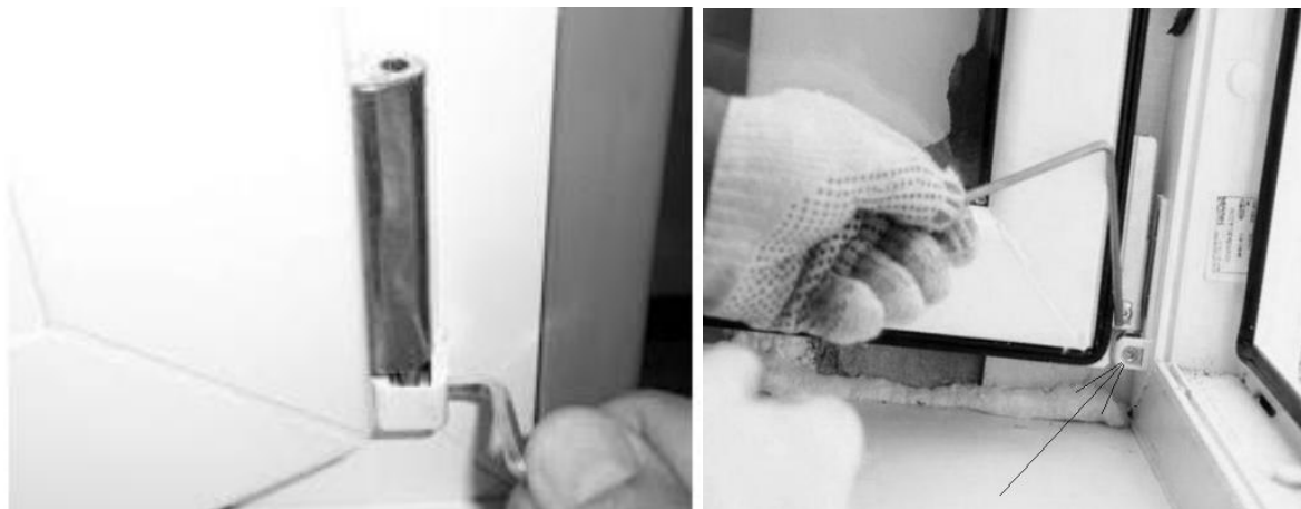
Рис. 12. Регулировка нижнего угла створки по горизонтали
