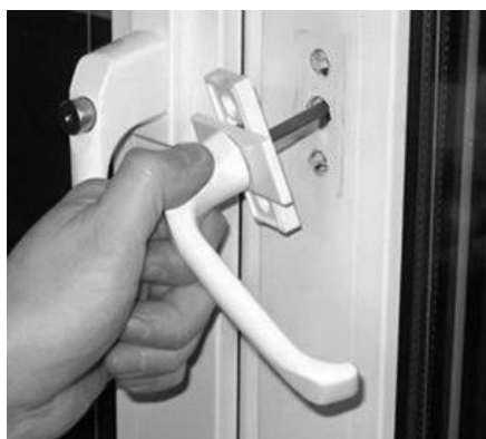
Рис. 16. Демонтаж старой ручки.
